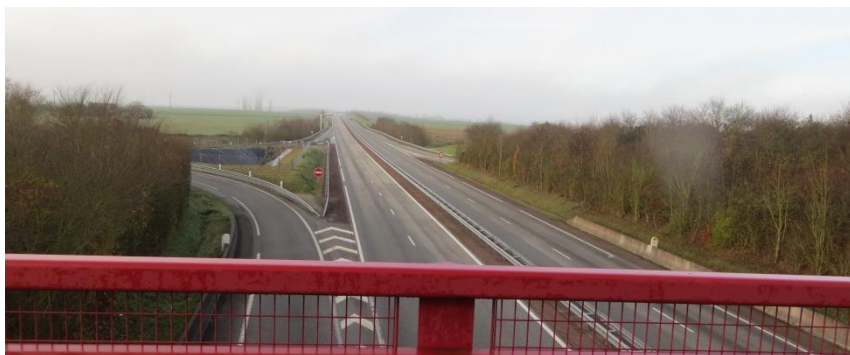
Passage sur la D926 au sud de L'Aigle, une véritable rupture marquant le paysage (source : Even conseil)
